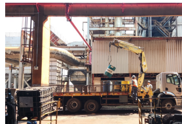
Coleta de resíduos realizado por empresa autorizada
